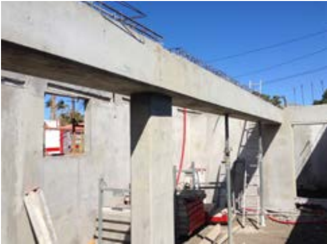
Poutres (Anne Mousse - Cambaie - St Paul)
