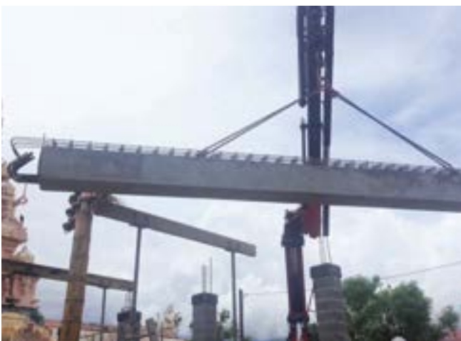
Poutres (Temple - St Louis)
