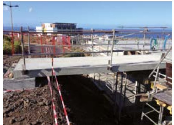
Passerelle («Jardin du Portail»)
