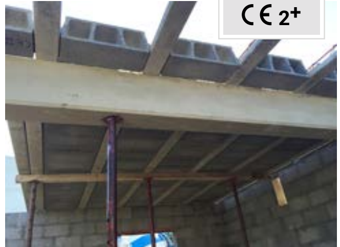
Poutres et plancher (Particulier - Les Avirons)
