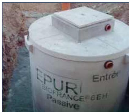
Cuve en béton fibré
