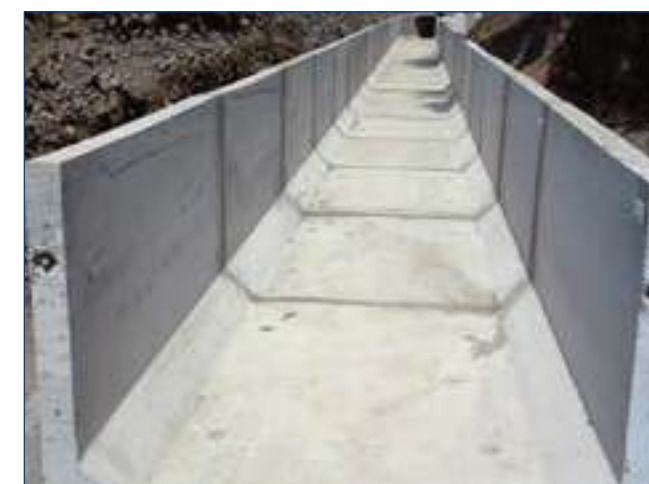
Caniveau à ciel ouvert à partir d'un cadre 100 x 150 cm - Aménagement Rivière St Denis
