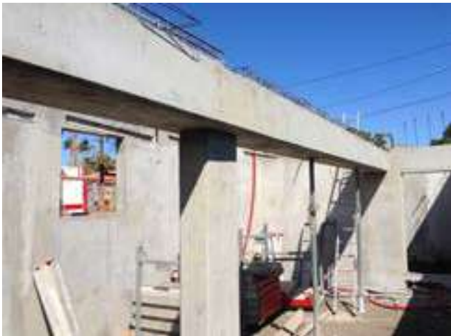
Poutres (Anne Mousse - Cambaie - St Paul)
