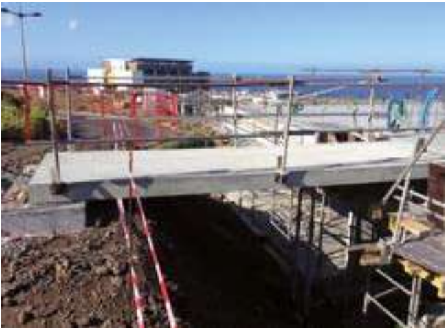
Passerelle («Jardin du Portail»)
