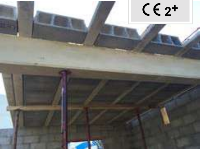
Poutres et plancher (Particulier - Les Avirons)
