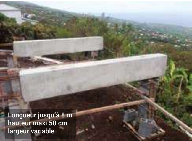
Poutres (Particulier - St Leu)
